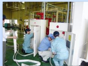
屋内消火栓操作体験
